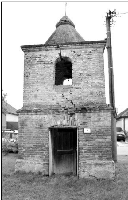
Zvonica v Páci v súčasnom stave pred rekonštrukciou
