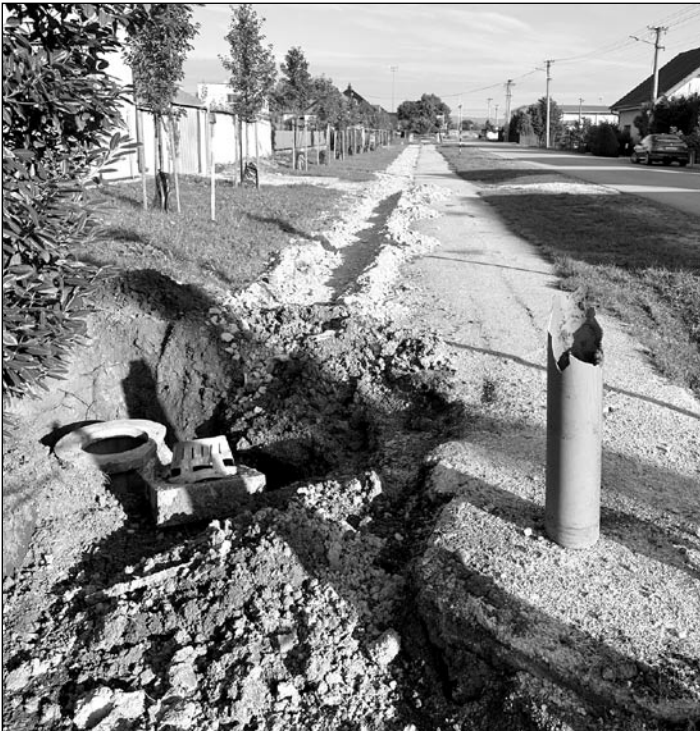
Dostavba chodníka na Štefánikovej ulici
