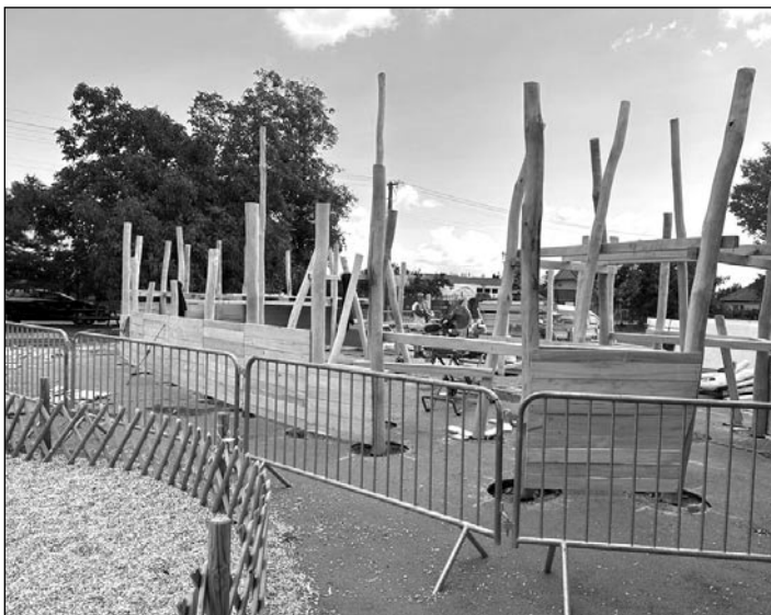
Výstavba inkluzívneho ihriska
