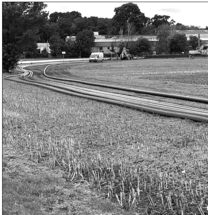
Výstavba vodovodu "Na Dolinách"
